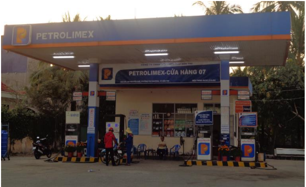
Hình 2: Khu vực mái che cột bơm
