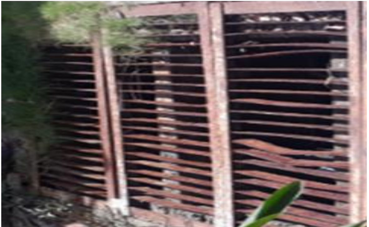
Hình 5: Bể gạn dầu và hố ga tại cửa hàng
