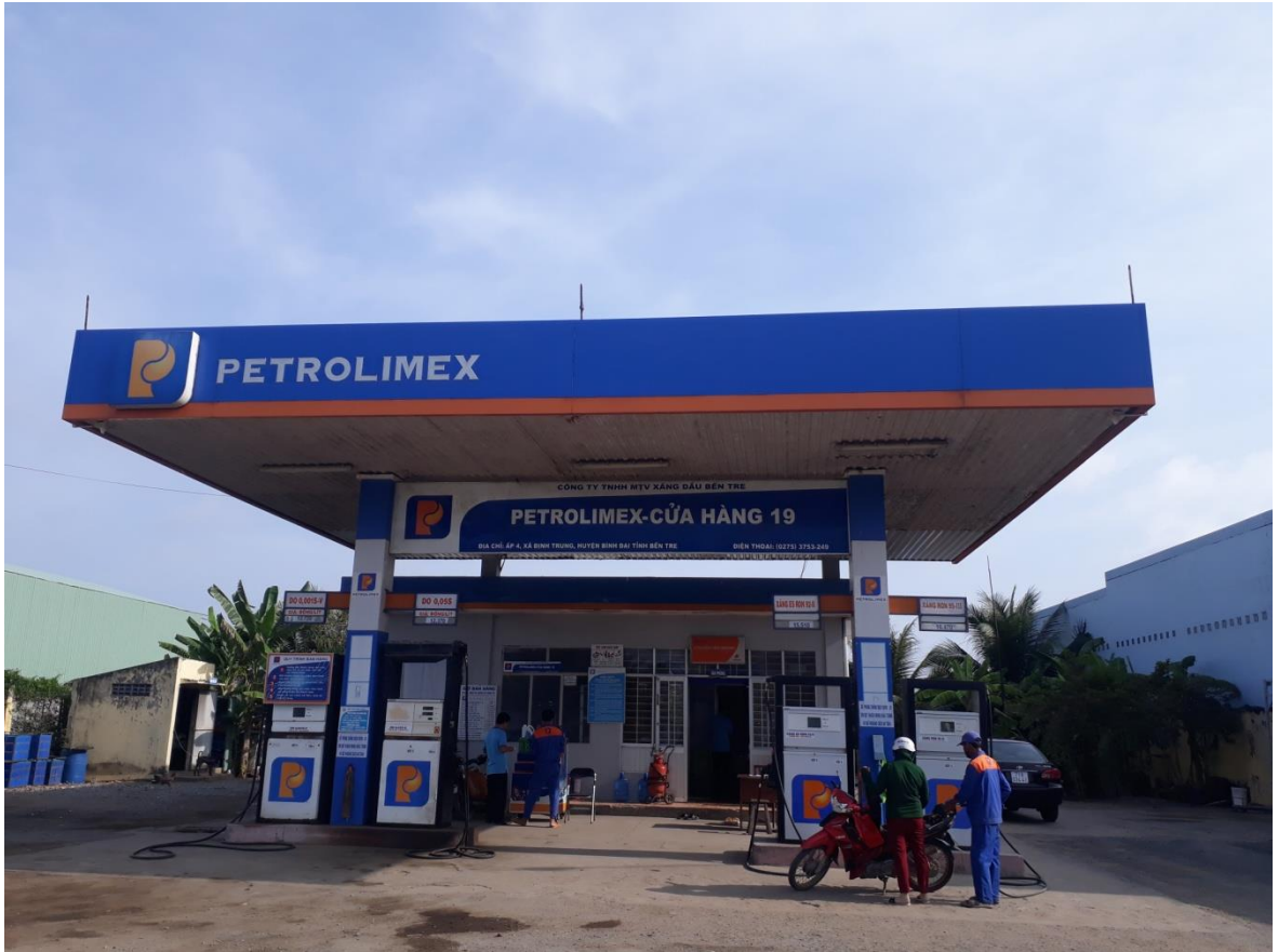
Hình 3: Khu vực mái che cột bơm
