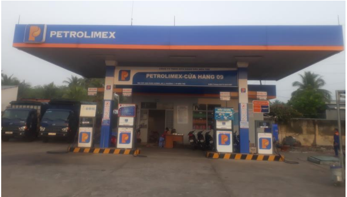
Hình 3: Khu vực mái che cột bơm
