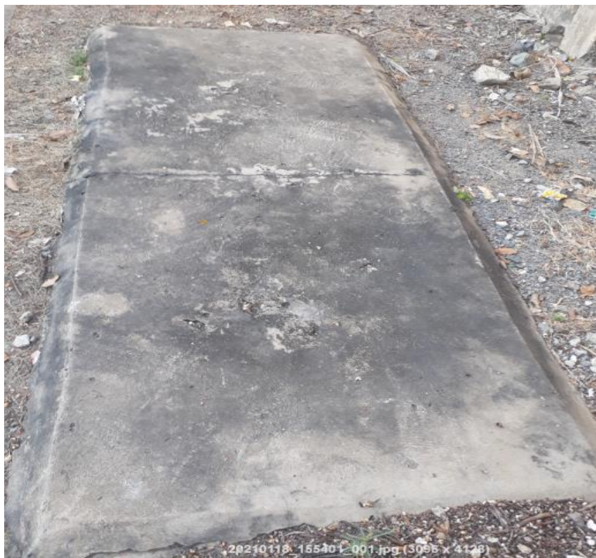
Hình 6: Bể gạn dầu và hố ga tại cửa hàng
