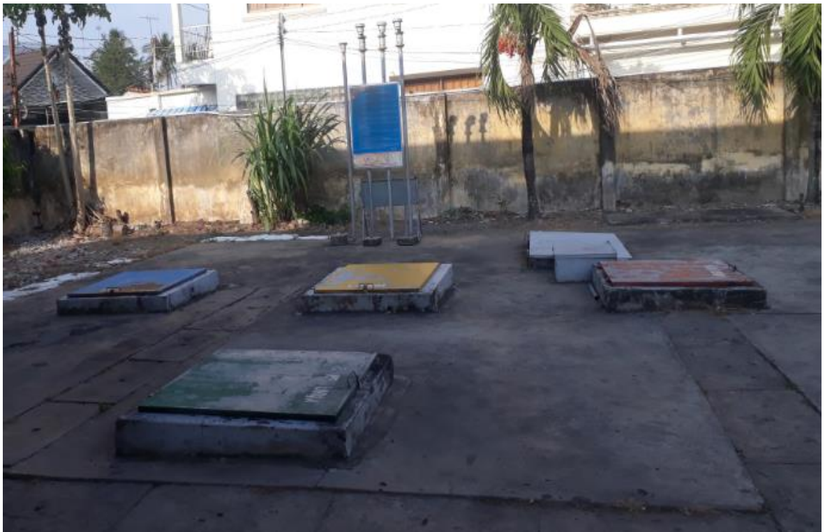
Hình 4: Khu vực bể chứa xăng dầu
