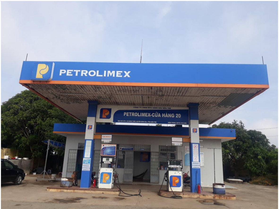
Hình 3: Khu vực mái che cột bơm
