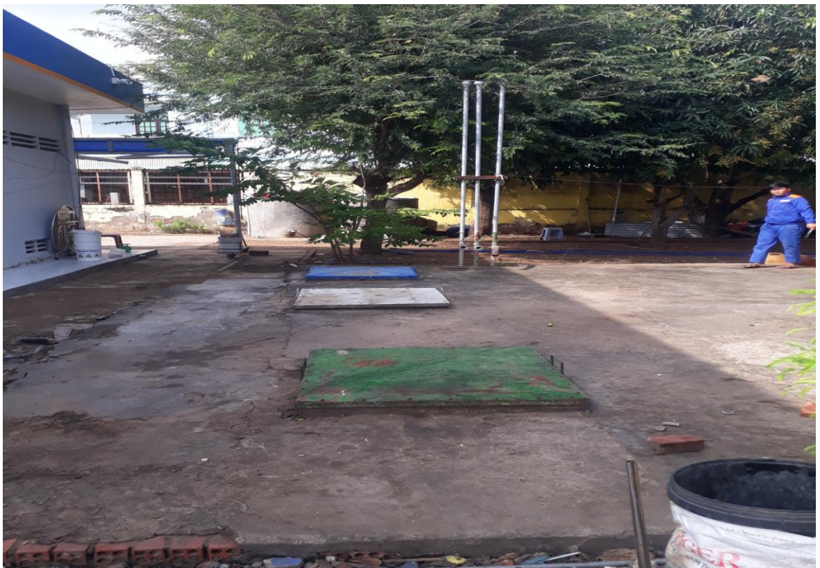
Hình 4: Khu vực bể chứa xăng dầu
