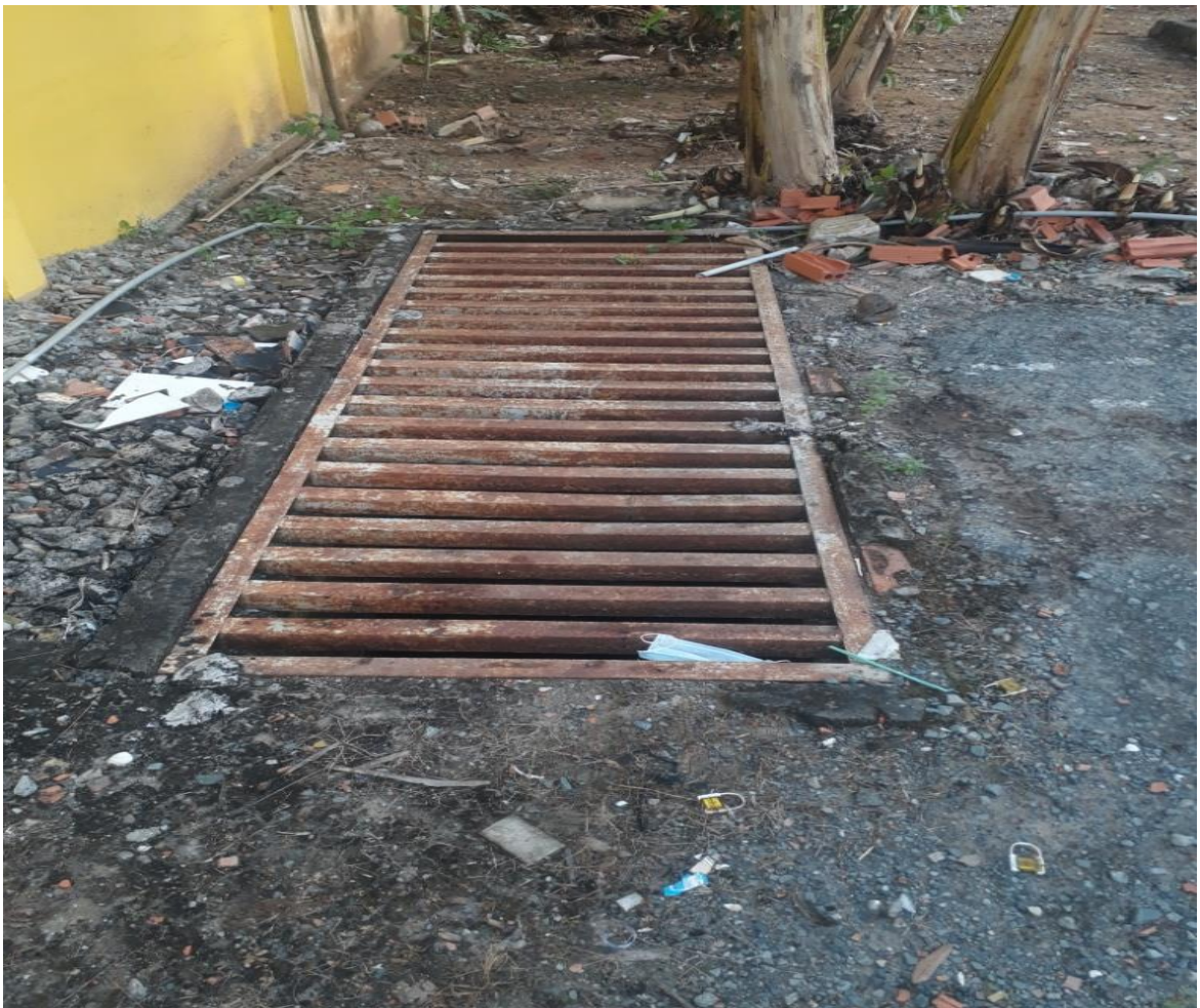
Hình 6: Bể gạn dầu và hố ga tại cửa hàng
