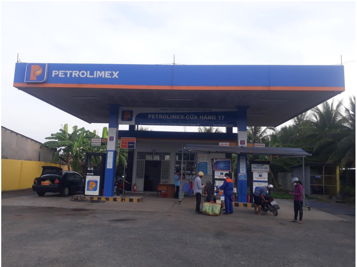
Hình 3: Khu vực mái che cột bơm
