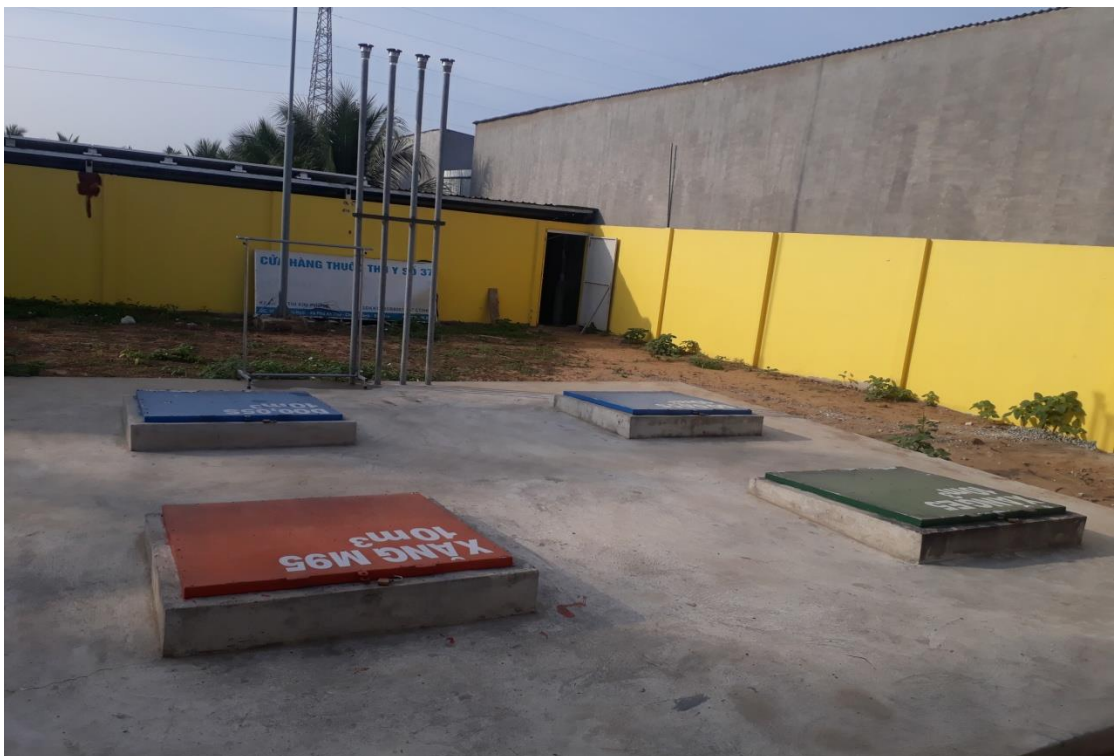
Hình 4: Khu vực bể chứa xăng dầu
