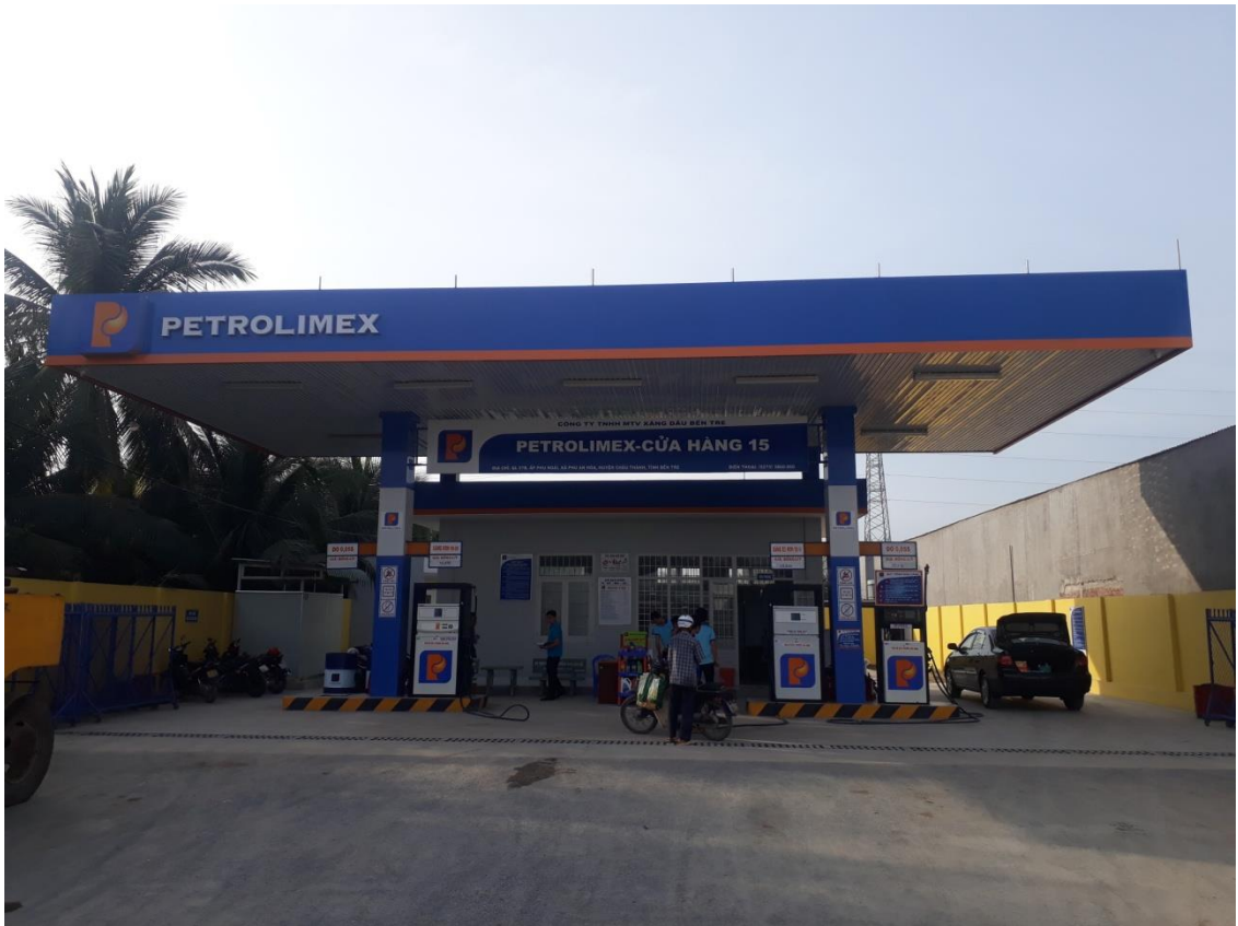
Hình 3: Khu vực mái che cột bơm
