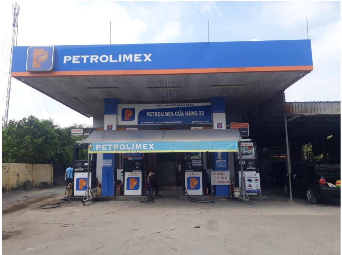
Hình 2: Khu vực mái che cột bơm
