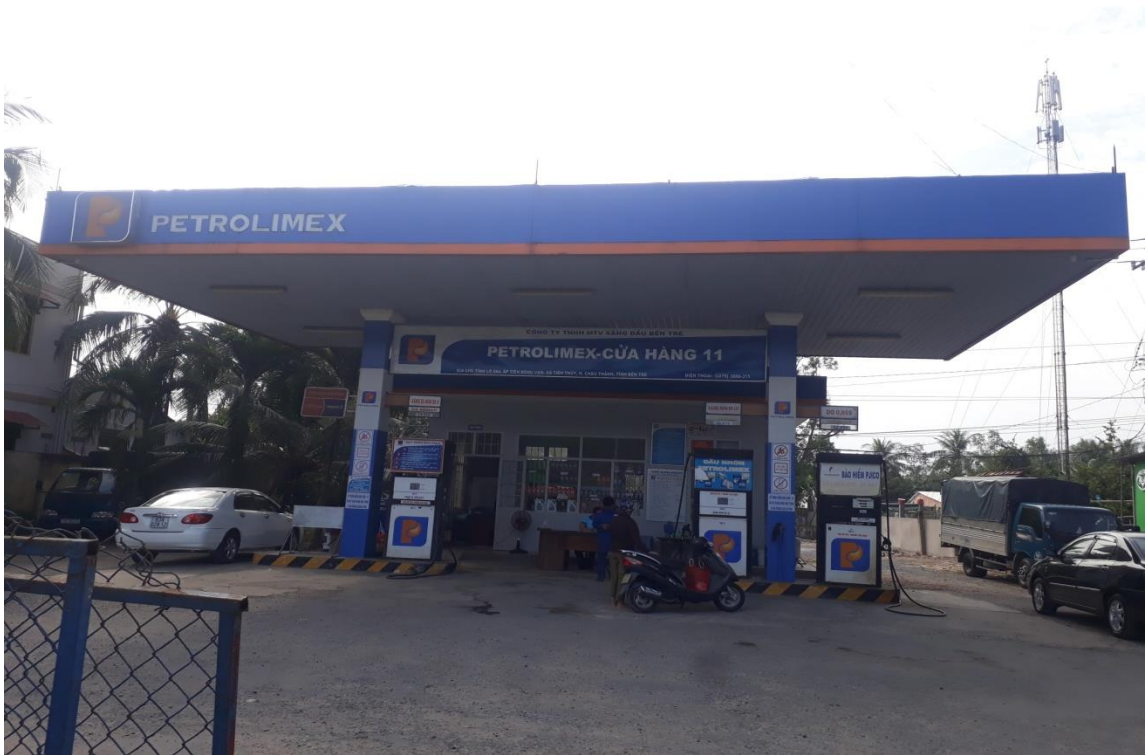
Hình 3: Khu vực mái che cột bơm
