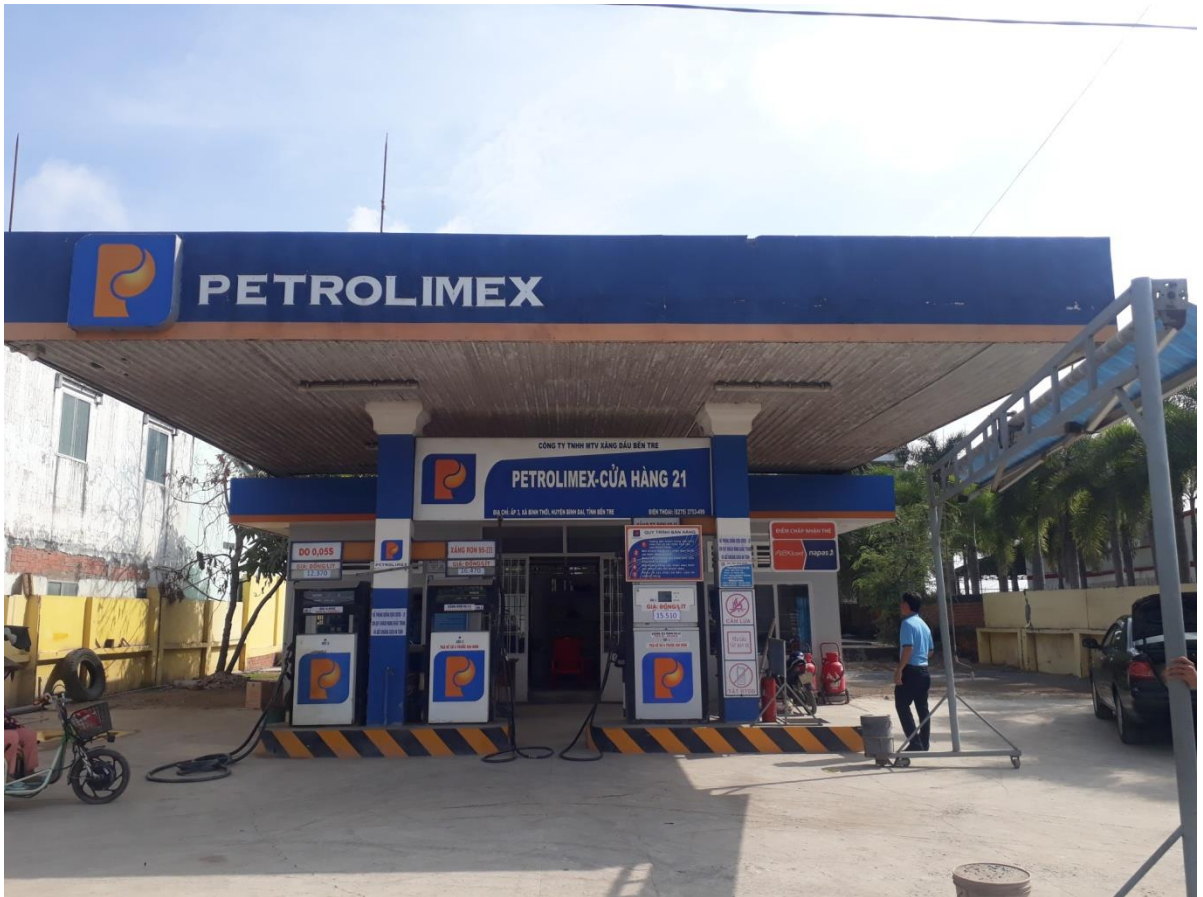
Hình 2: Khu vực mái che cột bơm
