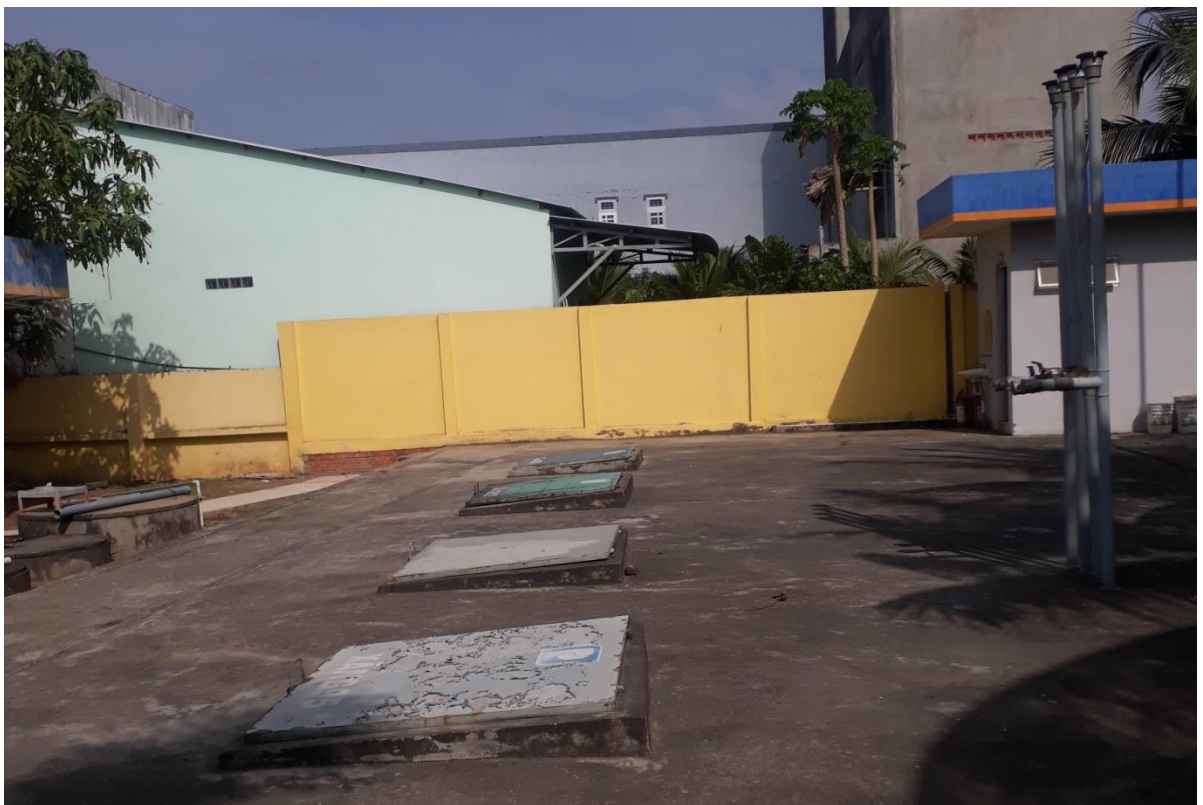
Hình 3: Khu vực bể chứa xăng dầu
