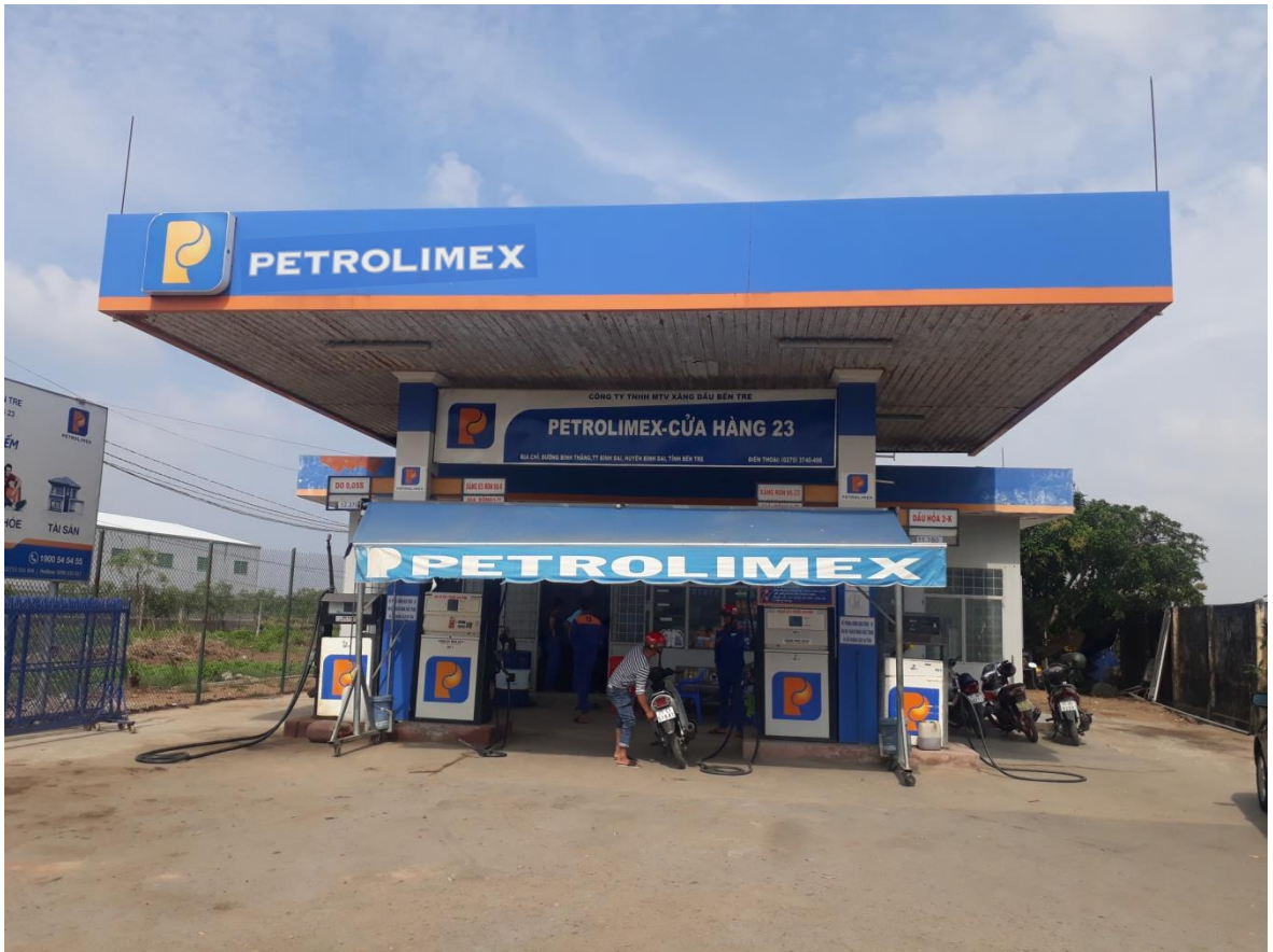
Hình 3: Khu vực mái che cột bơm
