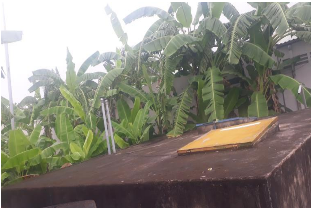
Hình 2: Khu vực bể chứa xăng dầu
