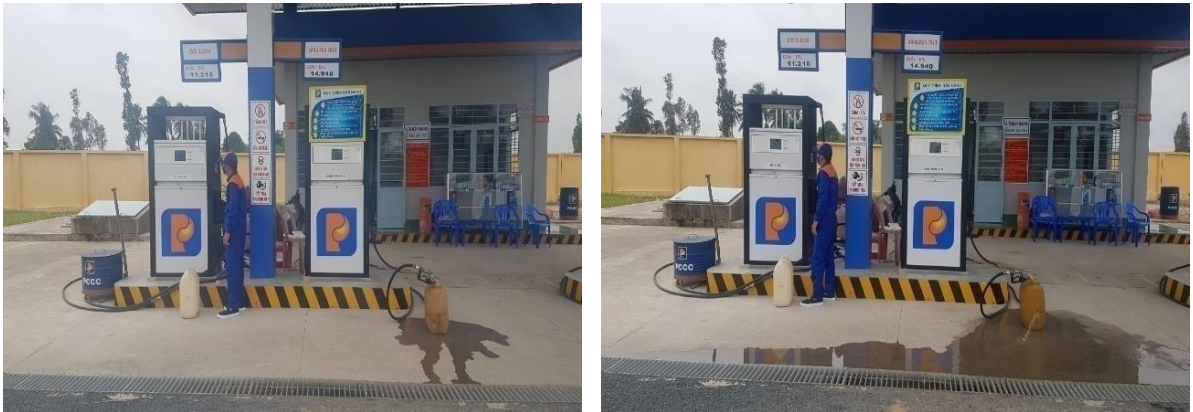
Hình 6: Minh họa sự cố bơm tràn dầu trong quá trình xuất hàng
