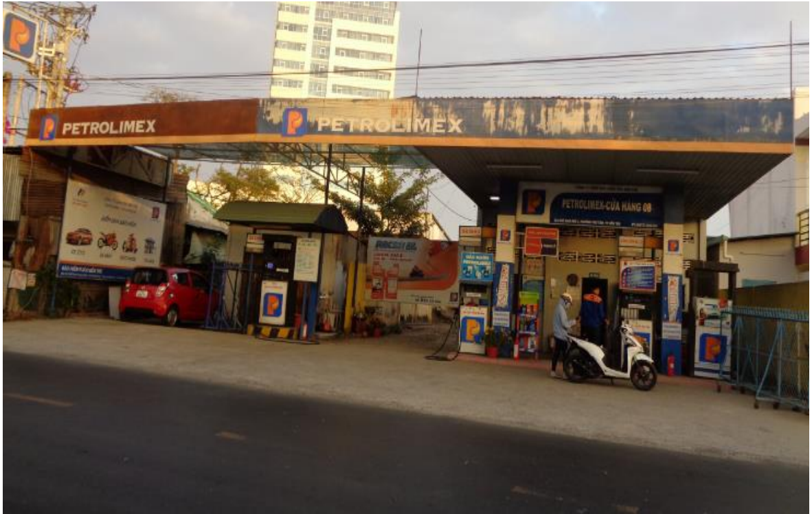
Hình 2: Khu vực mái che cột bơm
