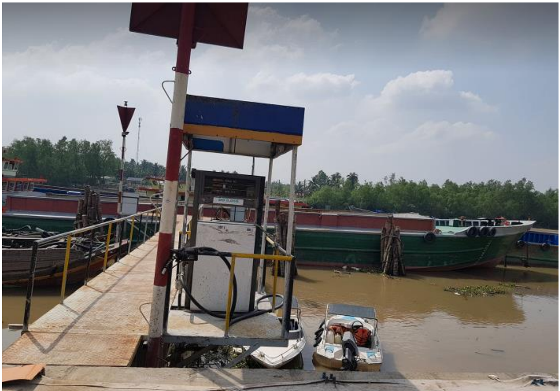
Hình 3: Khu vực mái che cột bơm
