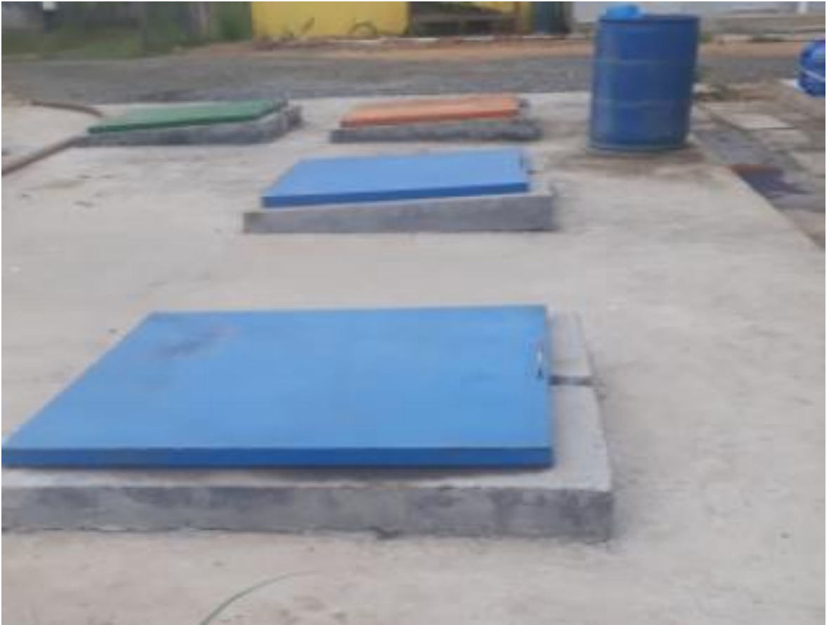
Hình 4: Khu vực bể chứa xăng dầu
