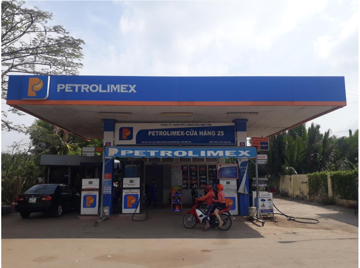
Hình 2: Khu vực mái che cột bơm
