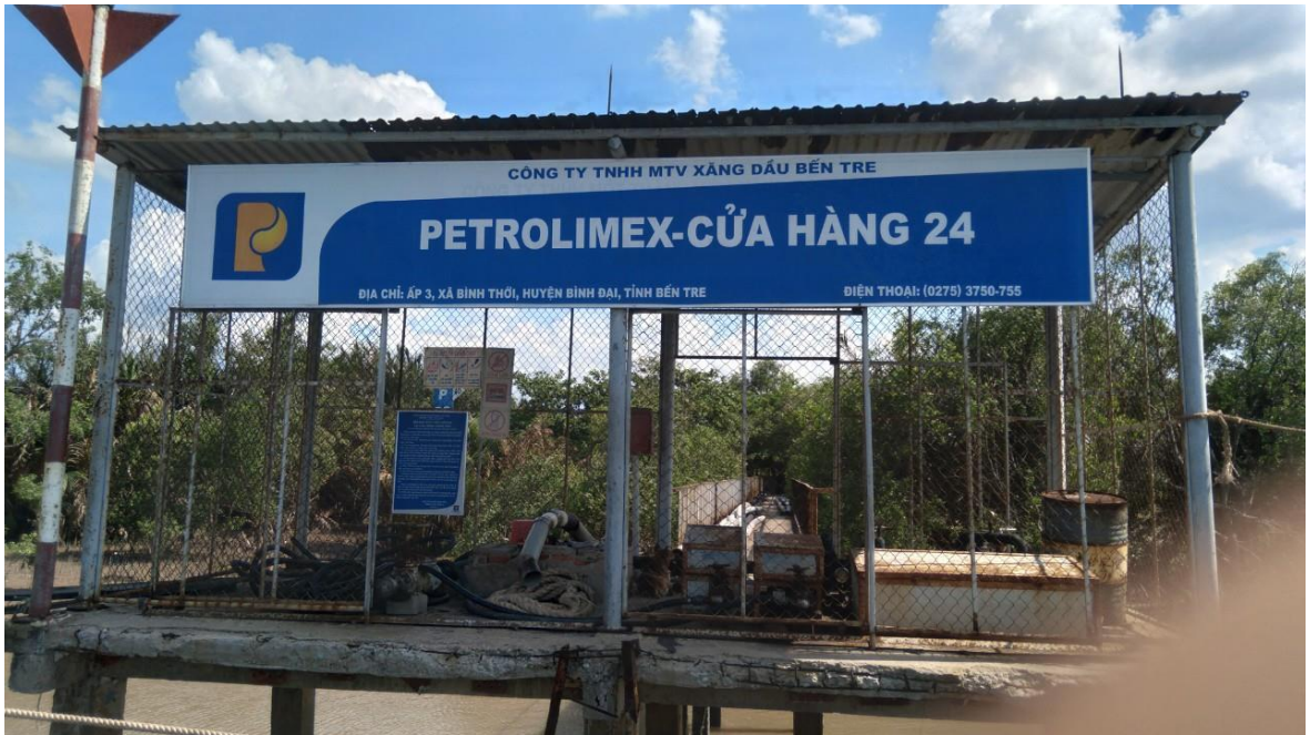
Hình 3: Khu vực mái che cột bơm
