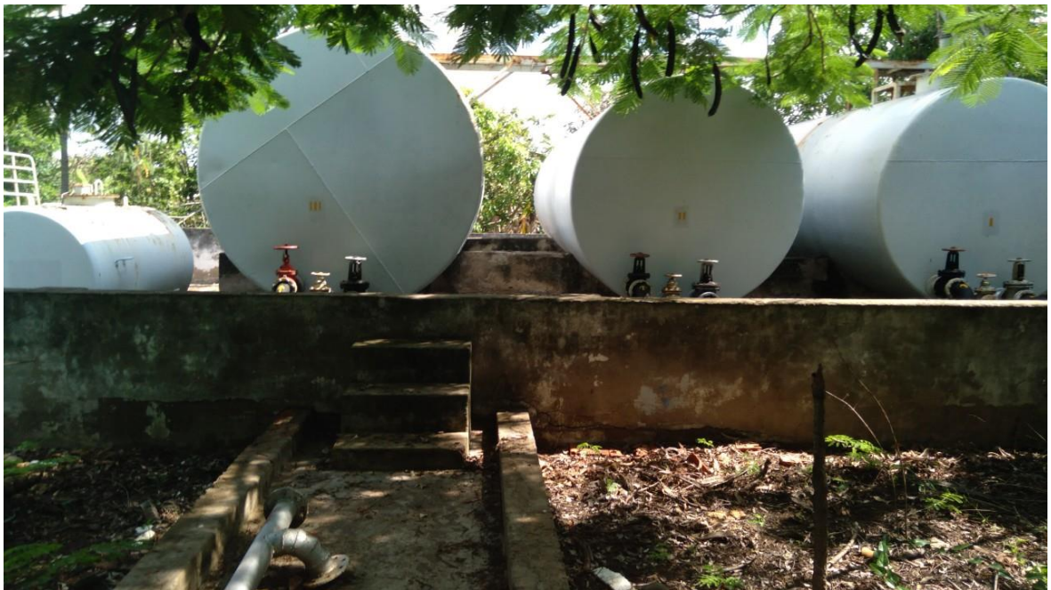
Hình 4: Khu vực bể chứa xăng dầu
