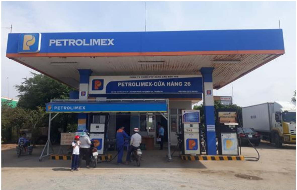
Hình 2: Khu vực mái che cột bơm
