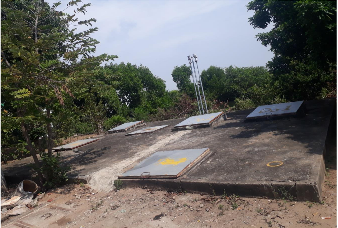
Hình 3: Khu vực bể chứa xăng dầu
